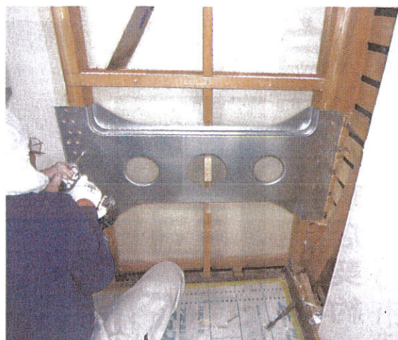
柱間に施工中の耐震デバイス
