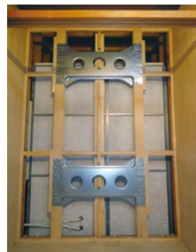
●木造用耐震デバイス施工後
