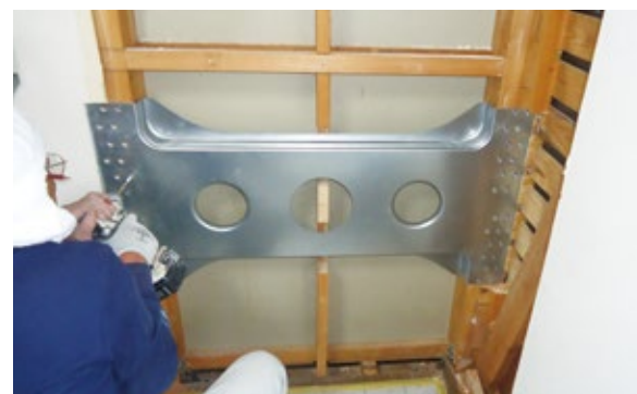
●木造用耐震デバイス施工作業
