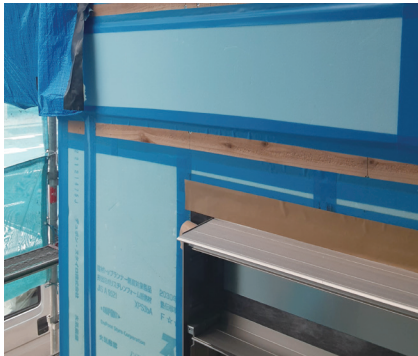
写真2 外壁の外断熱
