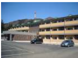
新日鐵独身寮(NSF工法) 構造・外装全く損傷なし
