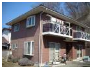
釜石戸建住宅(KC型) 損傷なし
