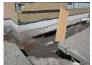
地盤沈下するも杭とべた基礎の上にスチールハウスは傾かずに残存
