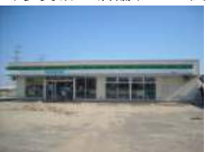
多賀城FM店舗。津波高さ約2m
