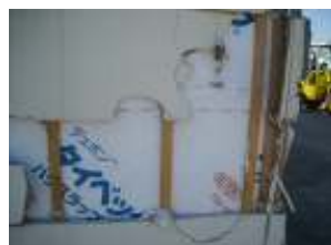
断熱材が耐力壁の緩衝材に
