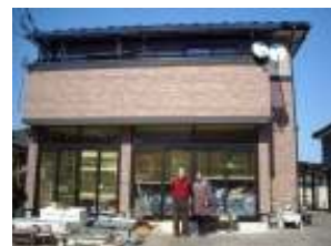
釜石戸建住宅(KC型) 損傷なし
