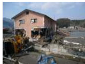
トラックが1階コーナー部に衝突し耐力壁破損するも建物倒壊せず(豊富な耐力壁量が効果発揮)
