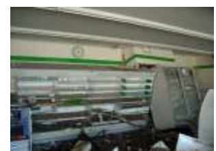
店舗内泥流入。什器破損
