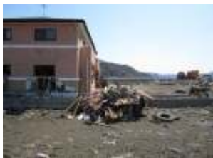
岩手県大槌町の津波の高さ約5m 周辺の建物ほとんど流失するもスチールハウス残存
