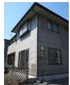
大槌戸建住宅(KC型) 損傷なし
