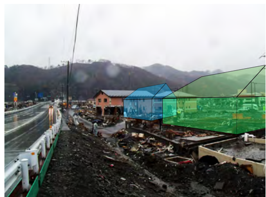
写真 29 木土台を残し流失した木造住宅
