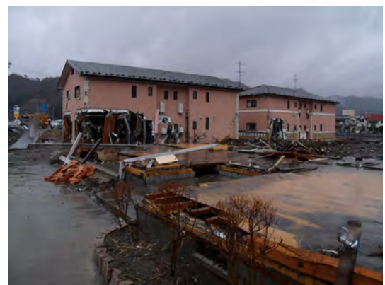
写真 4 共同住宅 A 棟， B 棟 背面
