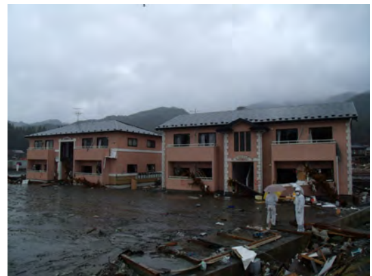
写真 3 共同住宅 A 棟， B 棟 正面
