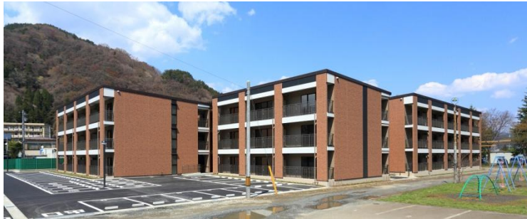
釜石市上中島町復興公営住宅第Ⅰ期 竣工写真
