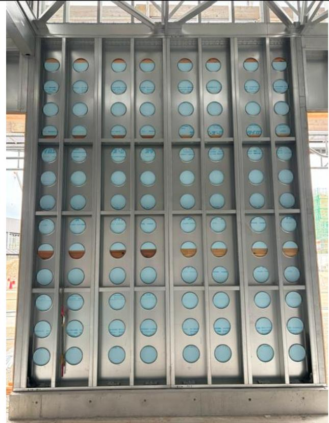
バーリング耐力壁（ハイパネル w3.6m×h4.5m）
